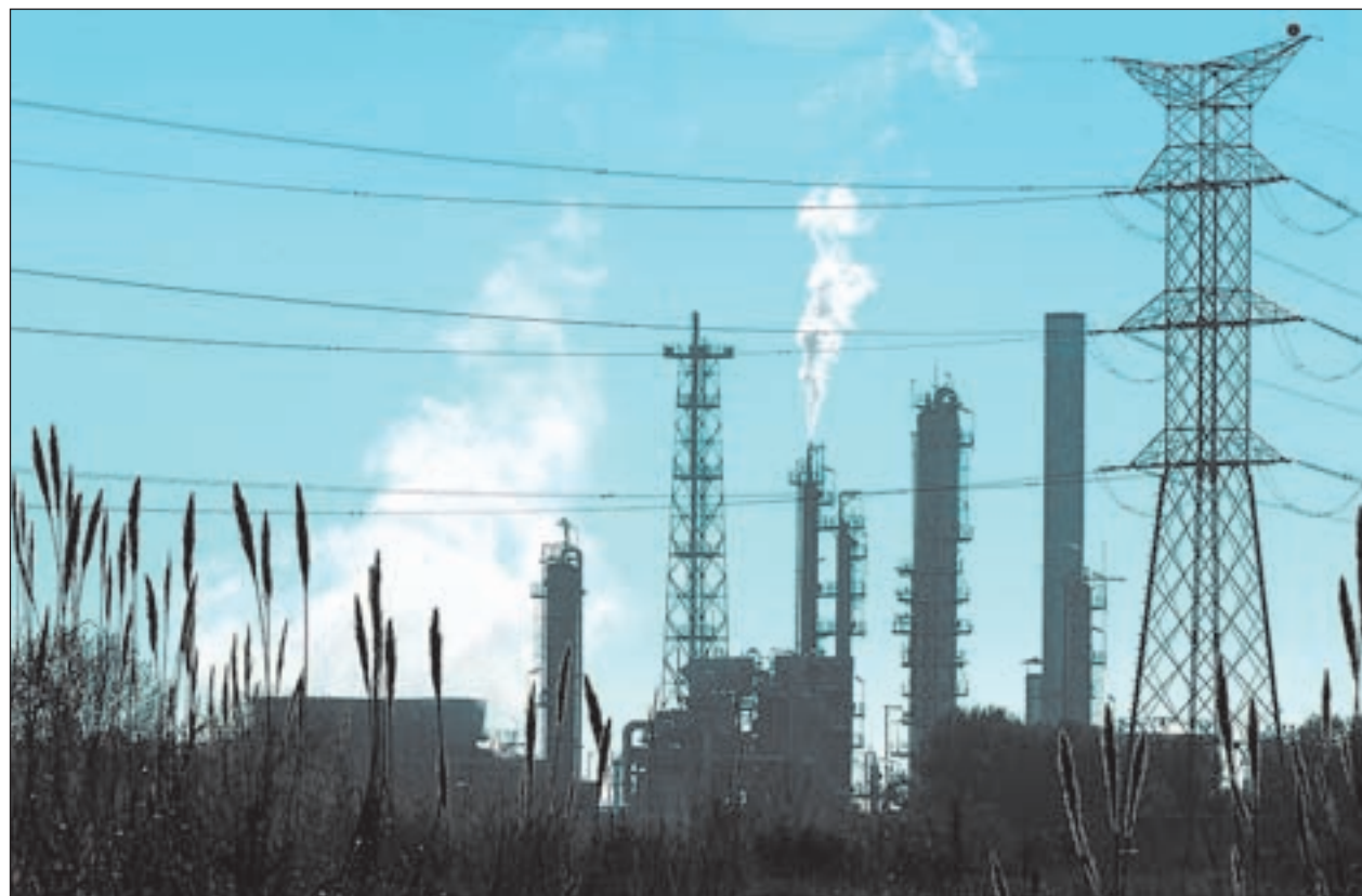
Chimeneas en pleno funcionamiento en el Polígono Petroquímico Sur de Tarragona.
