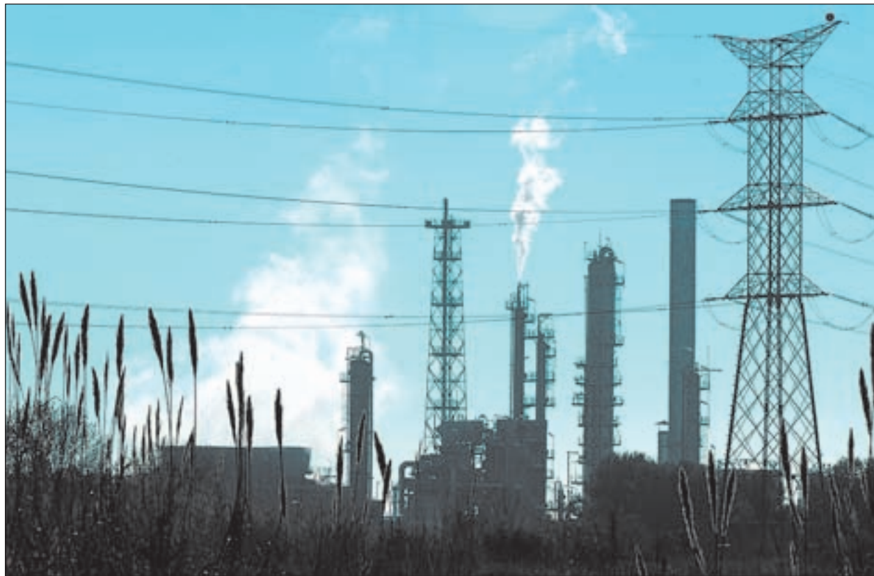
Xemeneies en ple funcionament al polígon Petroquímic Sud de Tarragona.
